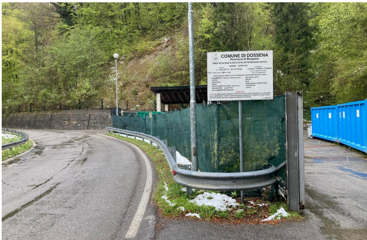
Figura 7.1 Ingresso sul lato destro
